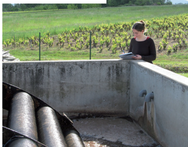
Le rotor assure à lui seul le brassage et l'aération du bassin de traitement.
